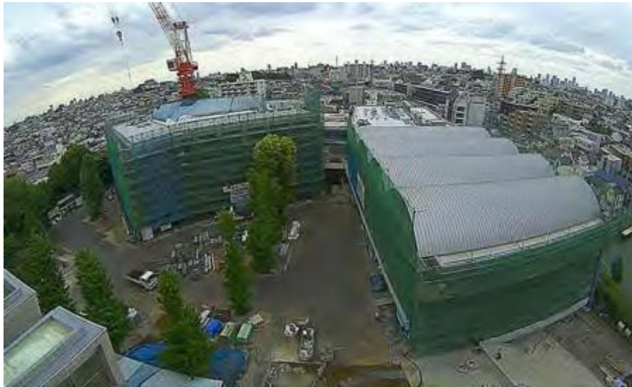
（新校舎建設状況＜2026年4月末＞）
