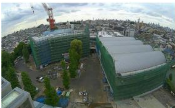
（新校舎建設現場：2026年4月末時点）
